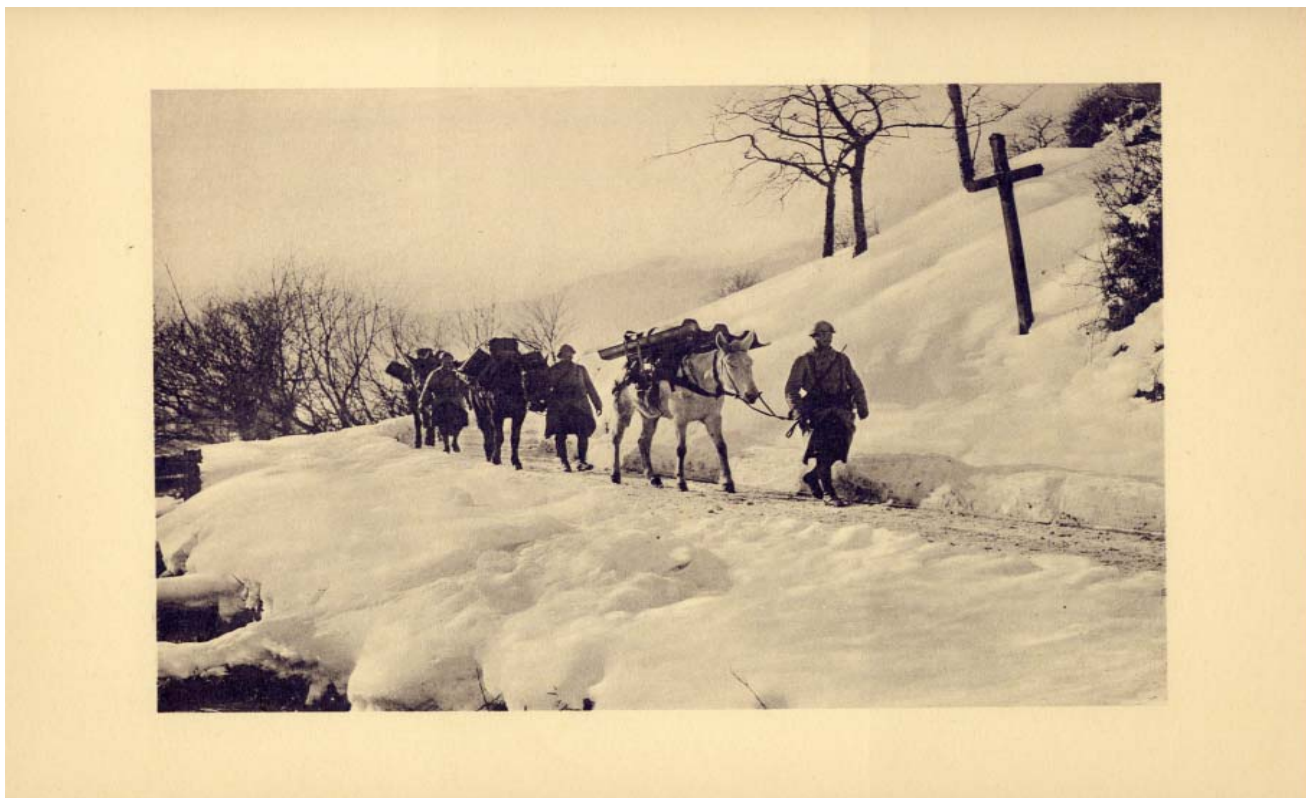
Convoi de mules transportant du matériel de tranchées, Alsace, 1917 (documentation Roland Bruneau)
